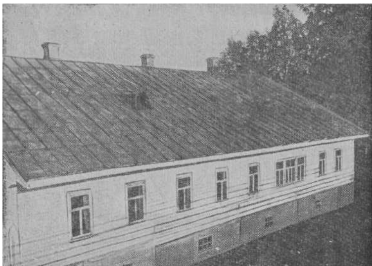
Бывшая заводская контора.
