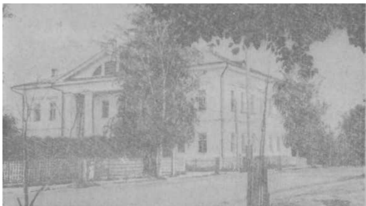
Здание окружного правления Строгановых, построенное в 1835—1838 годах.
